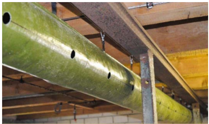
Рис. 7. Трубная система вентиляции
