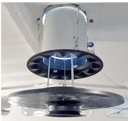
**Фото 1. Приточный камин FAC-2 с подмешивающим вентилятором**
