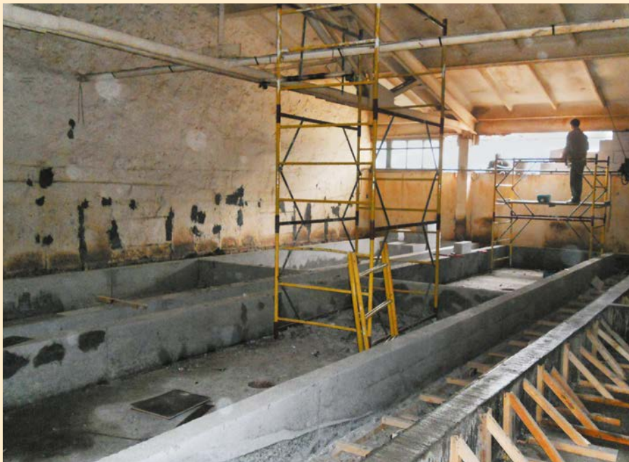
Проведение подготовительных строительных работ
