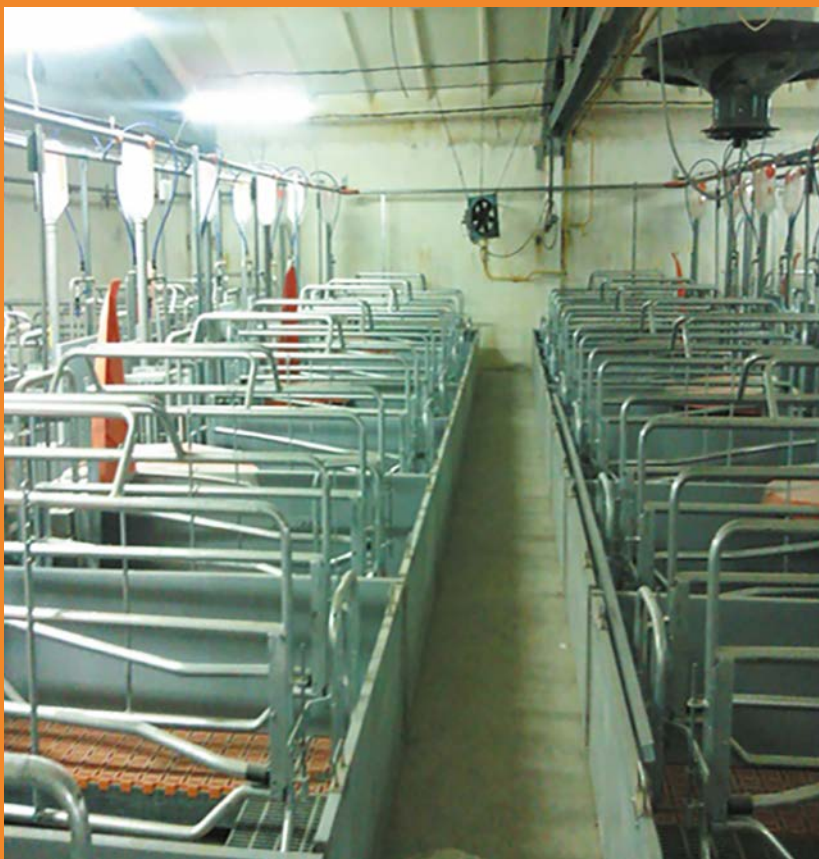
Сектор после реконструкции
