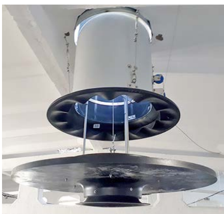
Фото 1. Приточный камин FAC-2 с подмешивающим вентилятором
