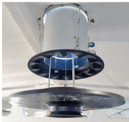
Фото 1. Приточный камин FAC-2 с подмешивающим вентилятором
