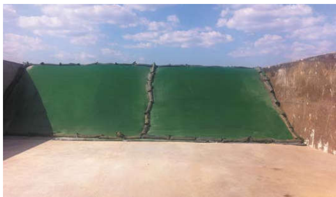
Траншея, укрытая по технологии «Силостоп», под ключ
